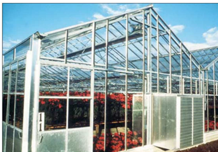
Figura 2-38: Esempio di Gutter-Connected Greenhouse
