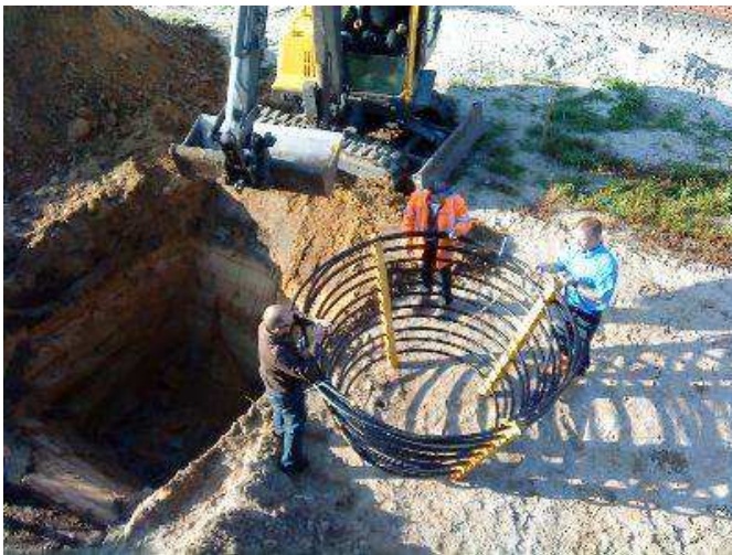
Figura 3-12: Collettore in trincea del tipo a basket e minicollettore a tubi paralleli
